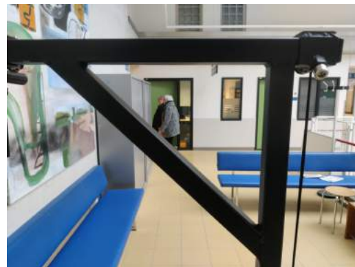
Figuur 5: De bovenconstructie van het HGT frame met de horizontale balk, verticale balk en de schoor.
