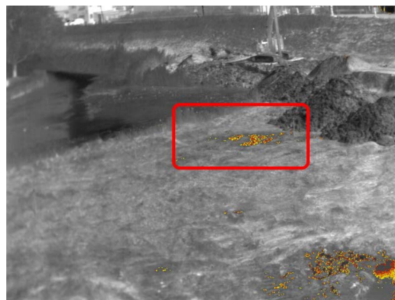
Figuur 2: Voorbeeld van opkomend water in een kwel door infraroodmetingen [8]
