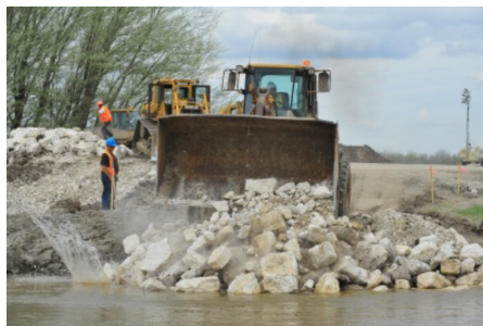
Figuur 16: Rots blokken noodmaatregel [PembinaValley, 2011].
