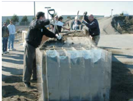
Figuur 15: Kunststof roostervloedwand met open cellen [Moore et al., 2014].
