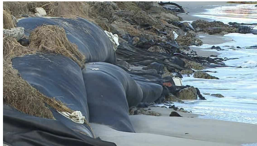
Figuur 26: Worsten gevuld met zand en of water noodmaatregel [Taylor, 2016].
