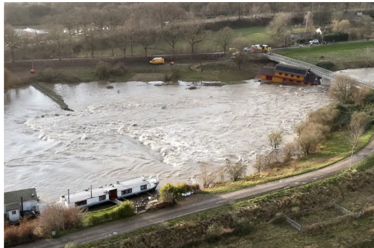
Figuur 5: De locatie van de bres met sterke stroming zichtbaar met op de achtergrond de woonboot die tegen de brug in Maastricht botste [Dijkstra, 2024].
