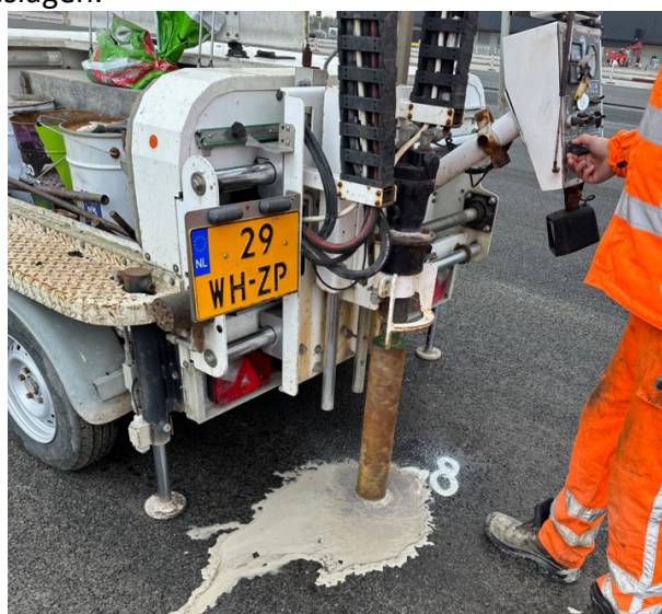
Figuur 17: Kern die geboord wordt.
