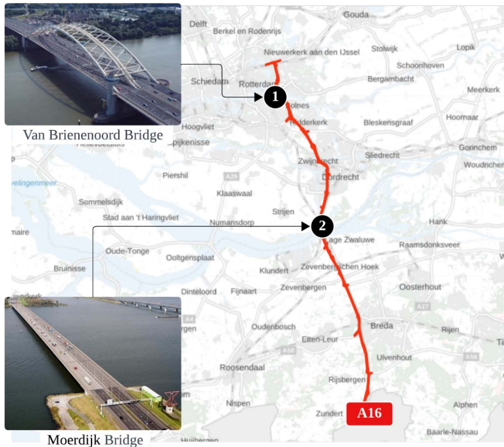
FIGURE 50: BRIDGES IN THE MOTORWAY A16 (GEO.RIJKSWATERSTAAT.NL, 2024)
