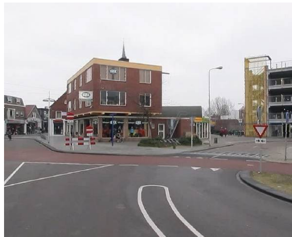
Afbeelding 9: Tweerichtingsfietspad in de Wemenstraat
