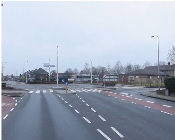
Afbeelding 10: Rotonde Deurningerstraat / Sloetsweg gezien vanaf de Deurningerstraat. Aan de rechterzijde is de rechtsaf strook te zien die richting de Sloetsweg gaat.
