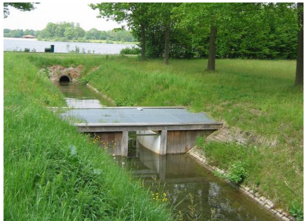
Figuur 2.6: Debietmeter in Fliert bij Bussloo.
