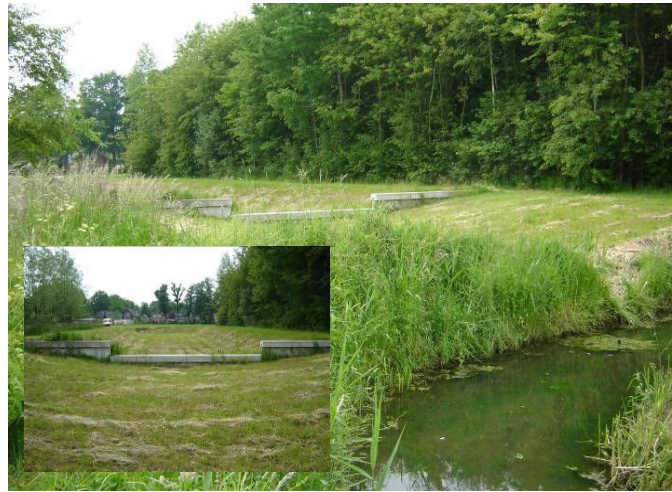
Figuur 5.11: Berging voor overtollig water. De retentie wordt afgesloten door middel van een betonnen overlaat constructie.
