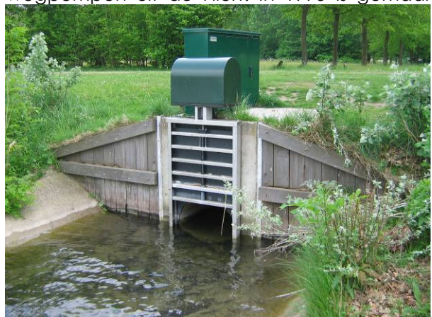
Figuur 2.5: Schuifstuw in Fliert bij Bussloo.
