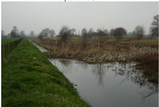
Figuur 5.10: Natuurvriendelijk ingerichte oever voor waterberging naast een watergang.
