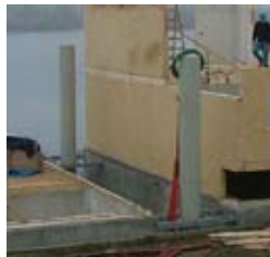
Figuur 32: Koppeling drijflichaam aan meerpaal
