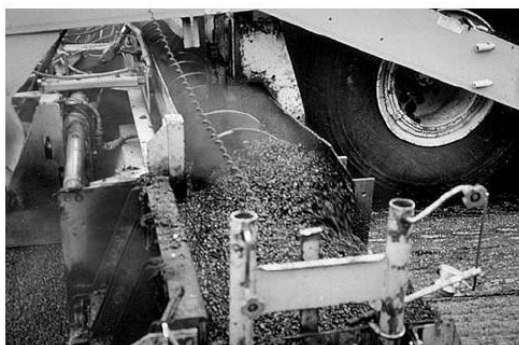
Figuur 4: Wormwiel voor gelijkmatige verdeling van asfalt over werkbreedte
