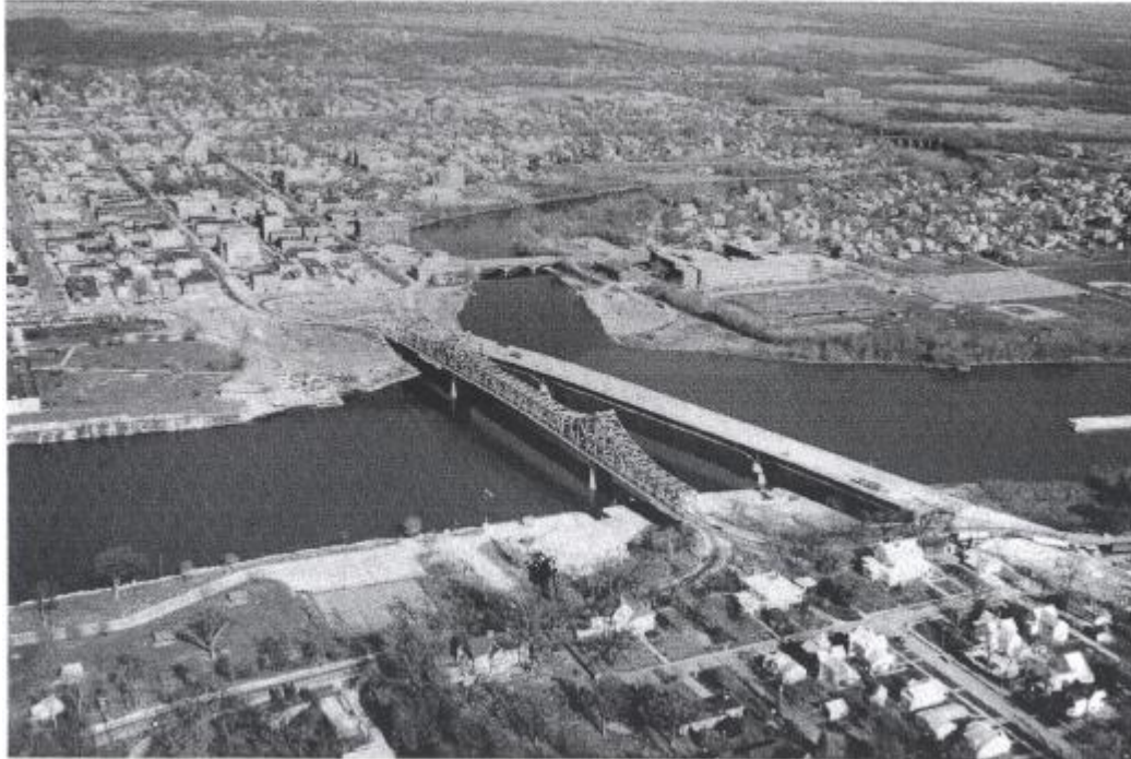
Bijlage 4D; Figuur 2: Foto voorbeeld project
