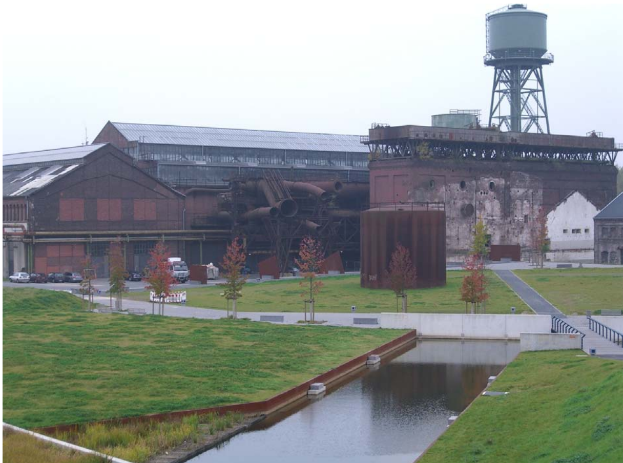
Rückseite der Jahrhunderthalle (Quelle: eigene)
