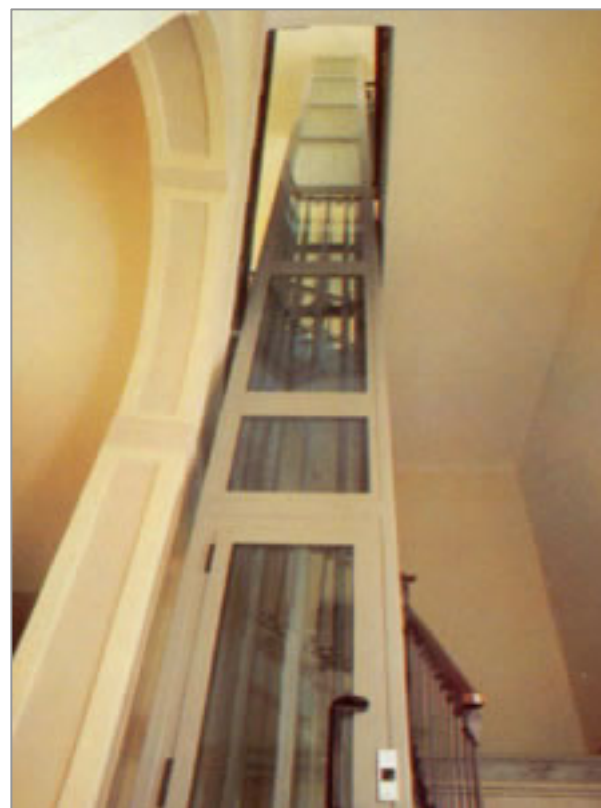
Figuur 48,49: respectievelijk een voorbeeld van een stoellift en een woonhuislift
