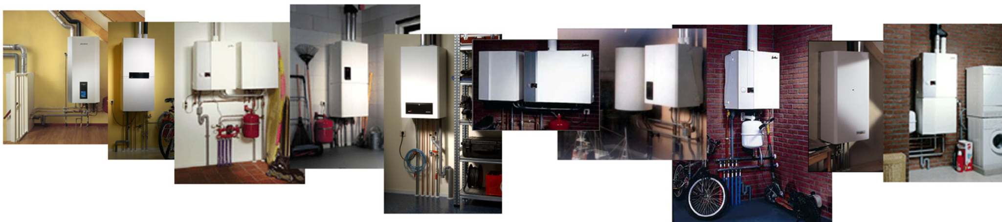
Figuur I Collage; Plaatsing van CV-ketels
