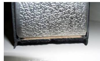
Afbeelding 8. De goederenscheider rust op het rubber
