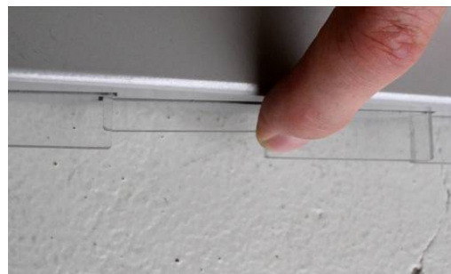
Afbeelding 26. Het indrukken van de lamellen.
