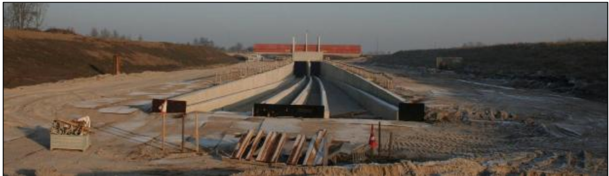
Figuur VII – 2: Tunnel Drontermeer, gezien vanuit Flevoland.
