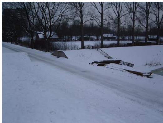
Figuur B7.2: Coupure in de zuidelijke kade langs het Almeloos kanaal met daarvoor de houten schutbalken.
