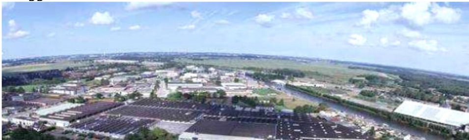
Figuur 1-3 Luchtfoto van APZ
