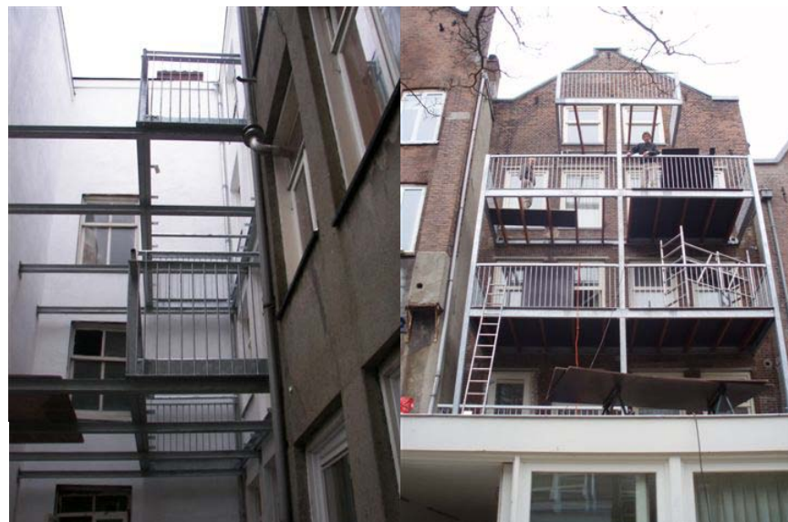
Figuur 3.5 Uitragende stalen constructies gebouwd voor een bestaande woning
