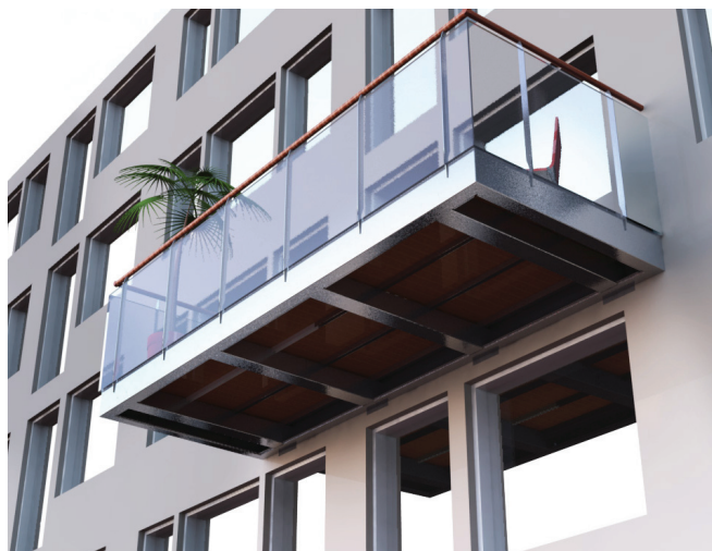
Onderaanzicht balkon: zonder onderbeplating
