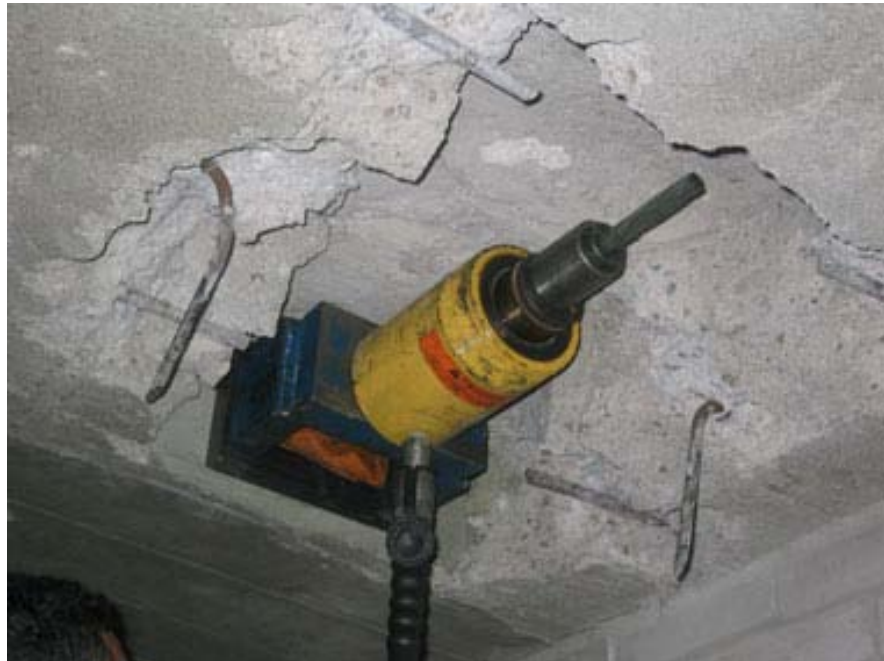
Figuur 7.2 Vijzel (geel) die gebruikt wordt om de kabels op spanning te zetten.
