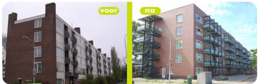
Figuur 3.7 renovatie project waarbij een (gedeeltelijk) zelfdragend staal constructie voor de flat is geplaatst
