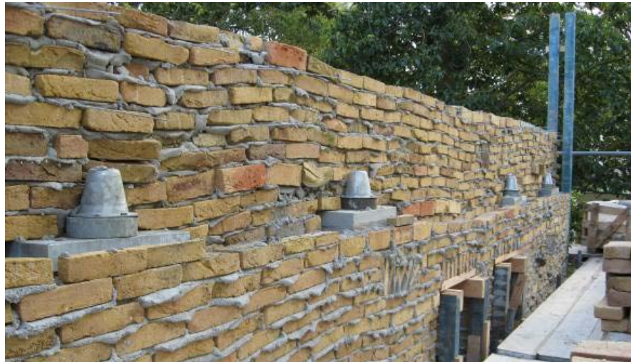
Figuur 7.9 spanmoer van de spanstrengen met een hoedje afgesloten tegen vocht.
