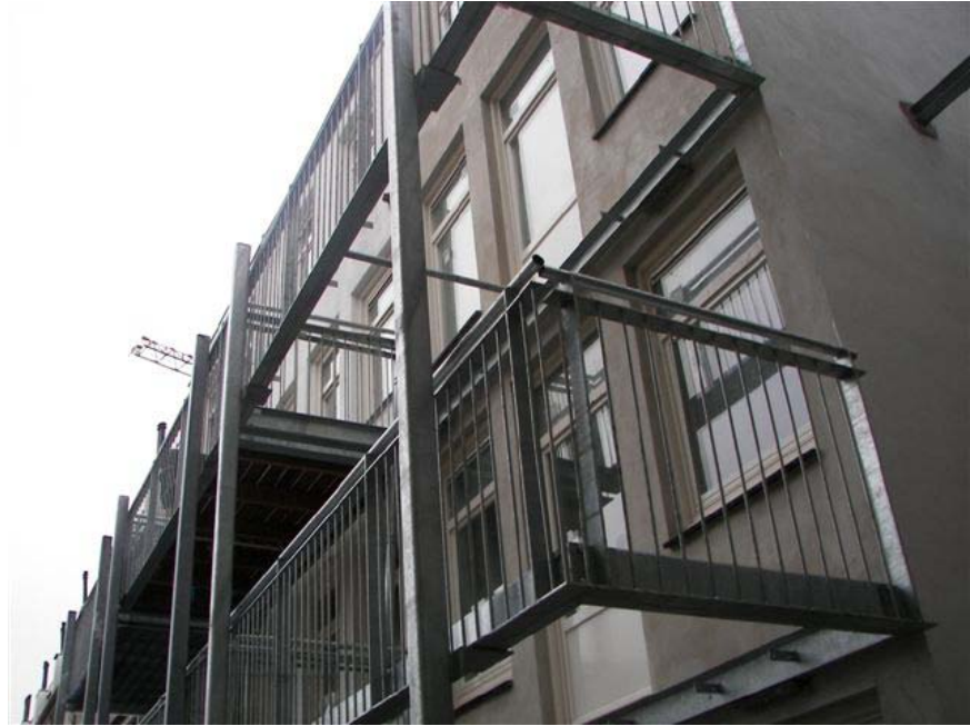
Figuur 3.6 Uitragende stalen constructies gebouwd voor een bestaande portiekflat
