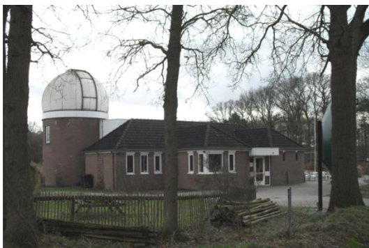
Afbeelding 2 Het sterrenwachtgebouw in Lattrop
