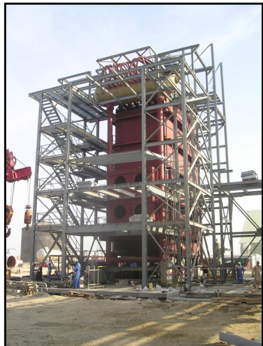
Figuur 8: Opbouw op locatie
