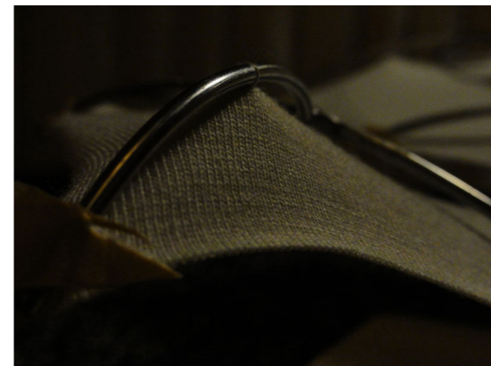
Detail van een 'opspan-punt', dit geeft de spanning aan het doek.
