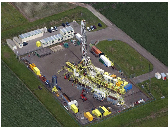
Figuur 6.1 Voorbeeld van een boorlocatie
