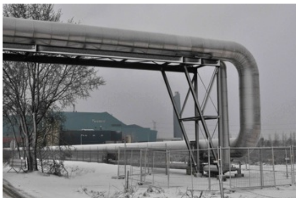
Figuur 3.9 De stoomleiding die stoom transporteert van Twence naar Akzo Nobel.
