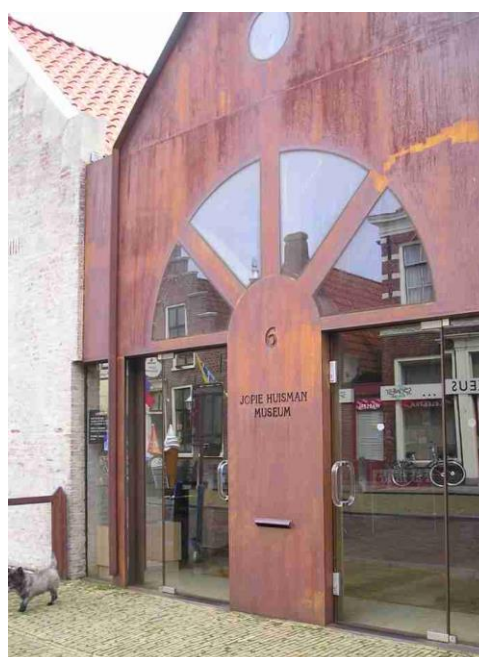
Figuur 15. Een voorgevel uit Cor-Ten Staal. Duidelijk is te zien hoe het materiaal een roestkleur heeft aangenomen. Her en der zijn enkele oneffenheden in kleur te zien, die het materiaal juist zo een natuurlijke look geven)
