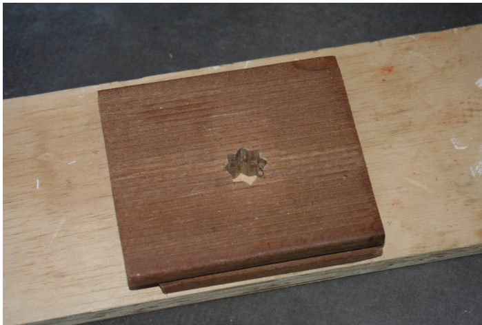
Afbeelding 10.1 - Lieraansluiting in hout
