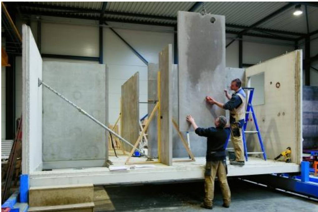
Plaatsing van de binnenwanden
