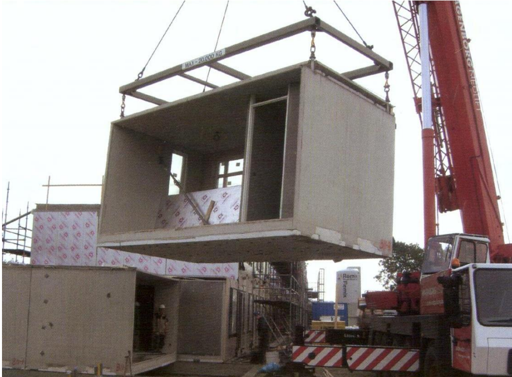
Plaatsing van de units op de bouwplaats
