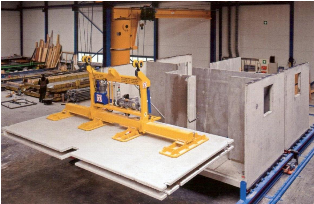
Plaatsing van de plafonds
