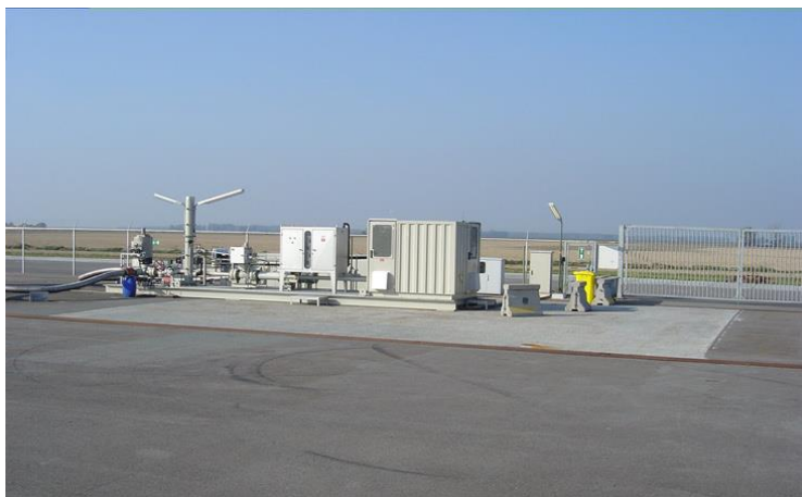
Figuur 58: Kleine gaswininstallatie zoals gebruikt bij Lauwersoog (Stork-GLT, 2012)
