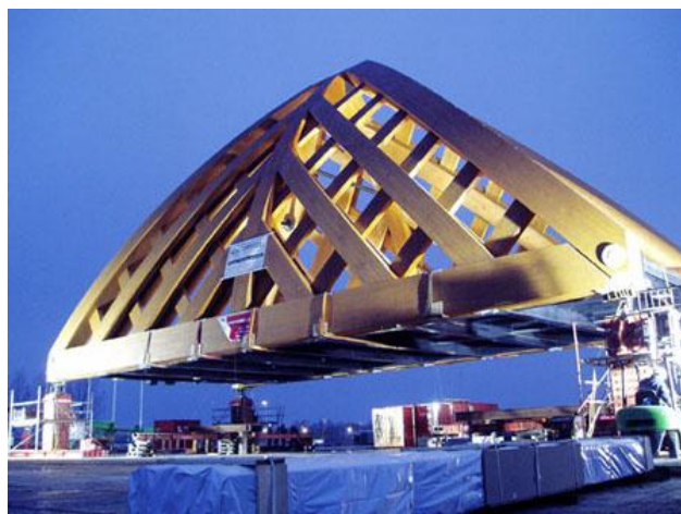
Figuur 9.8 Bouw brug in Sneek (Bron: AchterboschZantman)
