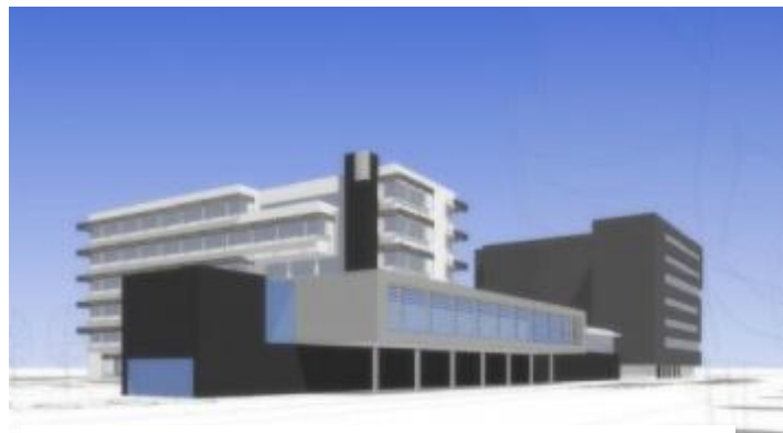
Figuur 9.6 Strippen oude politiebureau. Bij dit politiebureau werd een groot deel gestript, een andere vorm van aanpassen (Bron: BGDD architecten)
