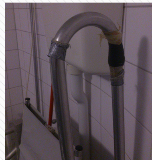
Afbeelding 7.2 - Om grip te verbeteren is tape op de toiletbeugel geplakt
