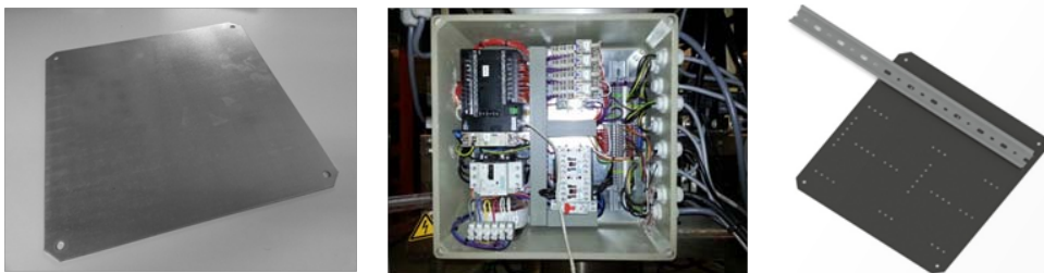
Afbeelding 3.22 Originele montageplaat; Volledige besturingskast; Voorgelaserde montageplaat met din rail
