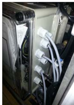
Afbeelding 3.23 Wartels in de besturingskast; Boormal wartels
