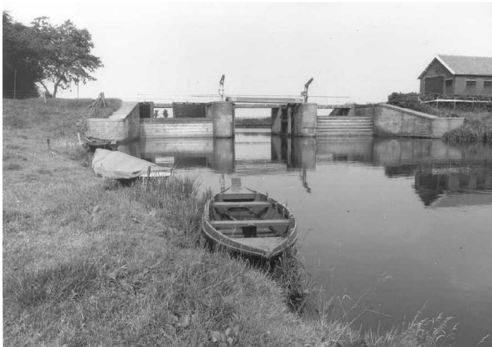
Figuur 16 De Gelderse Sluis in eind jaren zeventig (Historisch Centrum Overijssel, 2013). De schotbalken zijn in twee openingen geplaatst en rechts is de defensieloods te zien. Opvallend detail is dat er nog twee kranen aanwezig zijn op de sluismuren. In de huidige situatie is dit er nog één.
