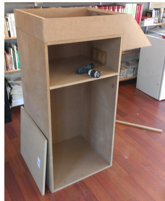
FIGUUR 39: BOVENKAST IN AANBOUW
