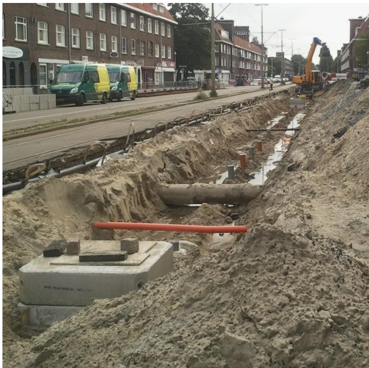
Figuur 4-3 Nieuw riool, deels aangevuld.
