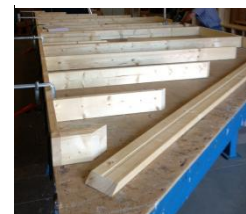
Figuur 55: Werktafel met topgevelframe
