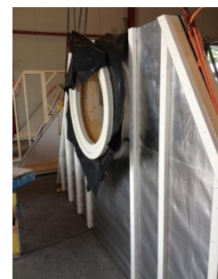
Figuur 60: Topgevel buitenzijde woning (met deklatten t.b.v. houtbekleding)
