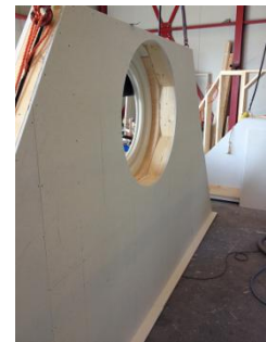
Figuur 59: Topgevel binnenzijde woning (Fermacell bekleding)
