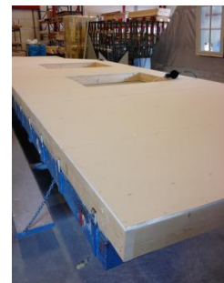
Figuur 57: Topgevel na aanbrengen gipsplaten
