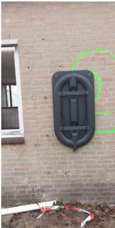
Figuur 18: plaatsing Gate Crasher op het midden van de muur.
