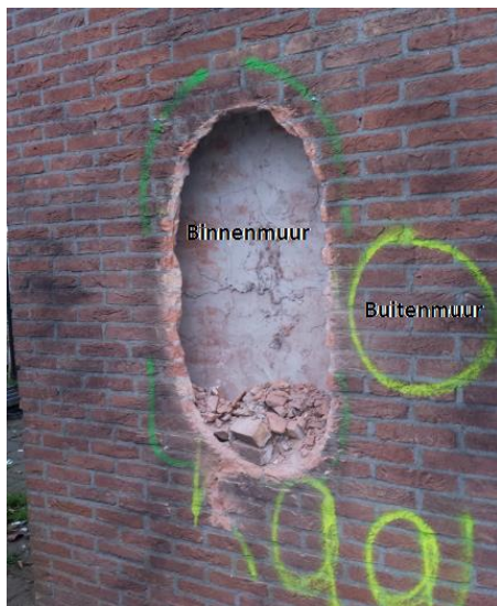
Figuur 2: opbouw spouwmuur gebouw 206 en 392.
