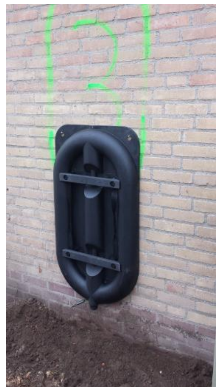
Figuur 17: plaatsing Gate Crasher aan de onderkant van de muur.
