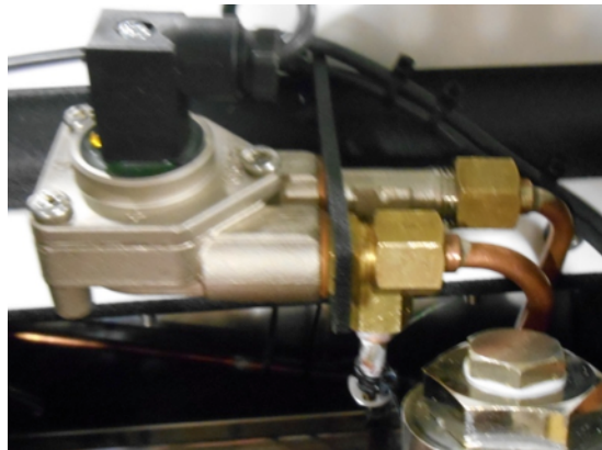
Afbeelding 7.5: De splitsing bij de flowmeter
