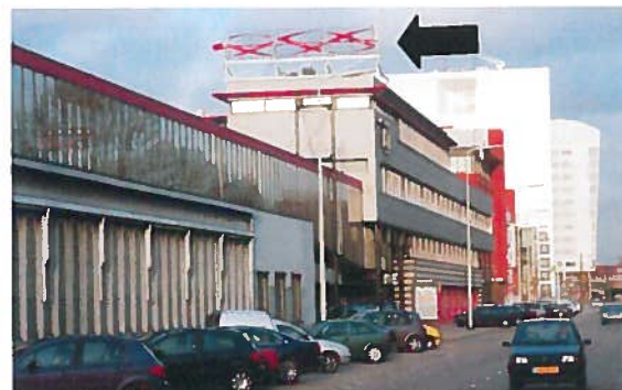
Figuur 13: in Den Haag is op het dak van het hoofdkantoor van de Haagse Tram Maatschappij een windturbine geplaatst: een Windwall. (2004) Een windwall draait rond een horizontale as. Dit houdt in dat het rendement afhankelijk is van de windrichting.
