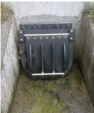
Figuur 33: terugslagklep
