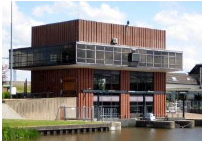
Figuur 12 - Gemaal De Drie Delfzijlen (Damsterdiepzijde) (De Nederlandse Gemalen Stichting, 2014)
