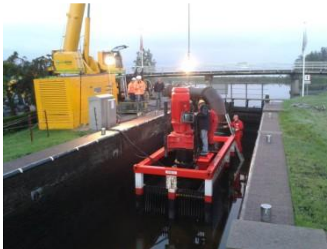
Figuur 10 - Pomp Van Heck in natte opstelling (Van Heck, 2013)
