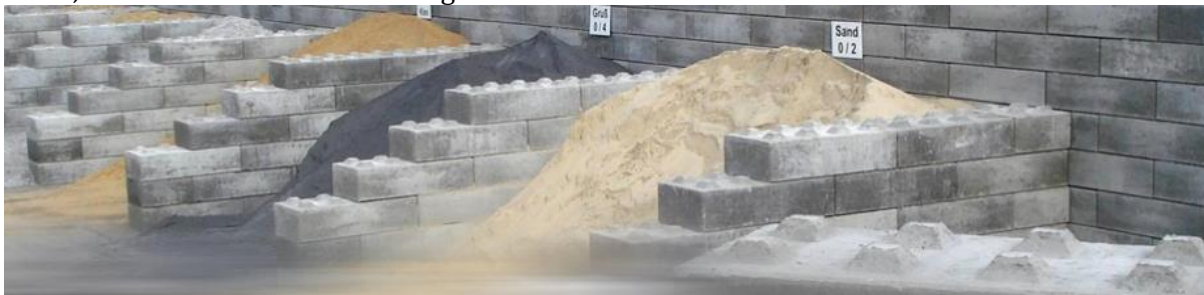
Figuur 1 flexibele betonnen bouwstenen gebruikt als keerwanden van materiaal. Bron: A. Jansen BV. (2015)
