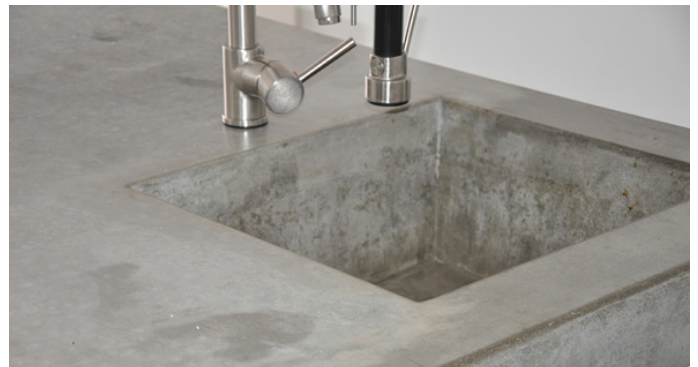
Afbeelding 6: Voor aanrechtbladen wordt regelmatig beton gebruikt, ook al is dit verre van het lichtste materiaal dat geschikt is voor deze toepassing. Toch heeft het materiaal voor veel mensen blijkaar een uitstraling die gewenst is in de keuken. ( www.betonnen-aanrechtblad.nl )
