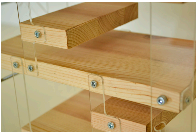
Afbeelding 55: Werkbladen, schappen en andere onderdelen worden bij elkaar gehouden door verschillende vormen uit plaatmateriaal.
