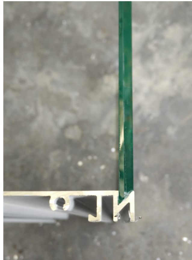
Afbeelding 5.2.1 - Verlijming tussen glas en profiel
