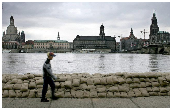
Figuur 6 - Voorbeeld van zandzakken
