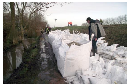
Figuur 11 - Voorbeeld van Big Bags ter stabilisering van de dijk
