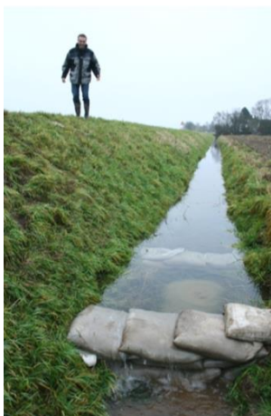
Figuur 9 - Voorbeeld van het gebruik van zandzakken om het peil in de kwelsloot op te hogen
