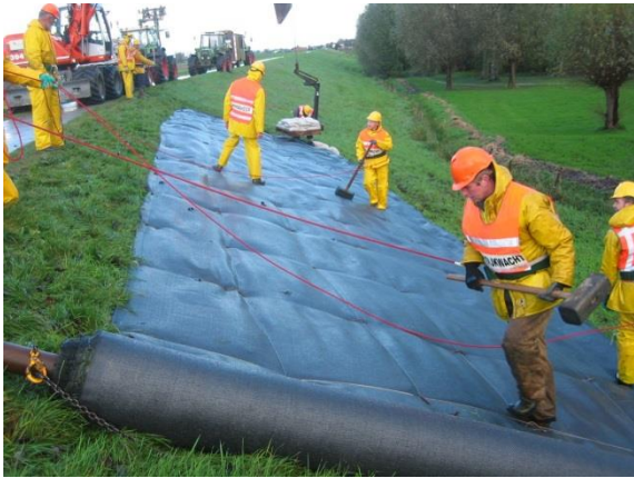
Figuur 12 - Voorbeeld van het aanbrengen van geotextiel
