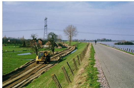
Figuur 8 - Voorbeeld van het aanbrengen van een berm
