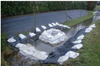
Figuur 10 - Voorbeeld van het opkisten van een wel
