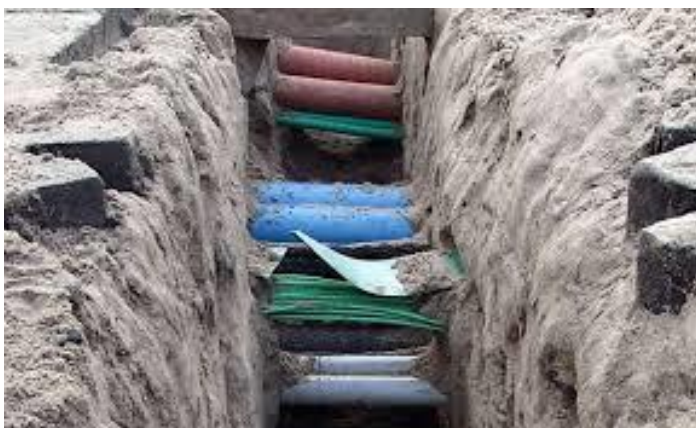
Figuur 16: Voorbeeld van proefsleuf (Graaf van der, 2014).
