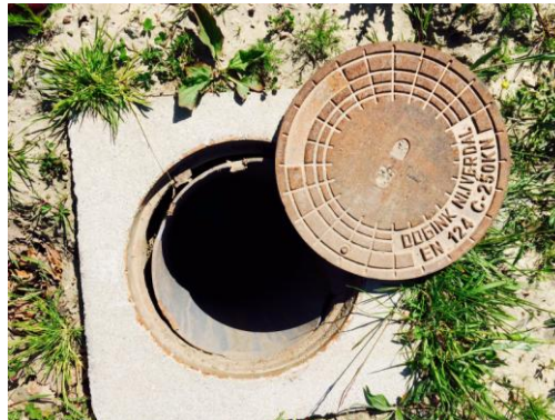
Figuur 26 Inspectieput wadi
