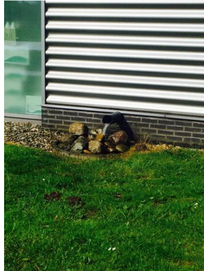
Figuur 23 Water wordt vanuit put afgevoerd richting wadi
