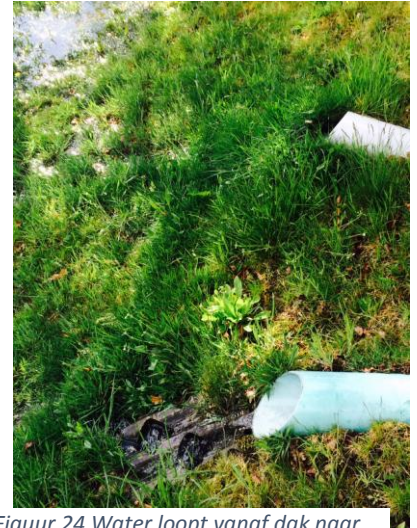
Figuur 24 Water loopt vanaf dak naar een afvoerput
