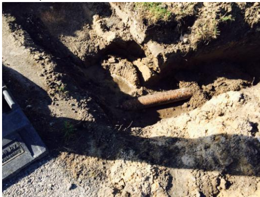
Figuur 32 stalen mantelbuis op Campus
