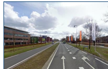
Figuur 17: Meetlocatie Kanaal Noord te Apeldoorn
