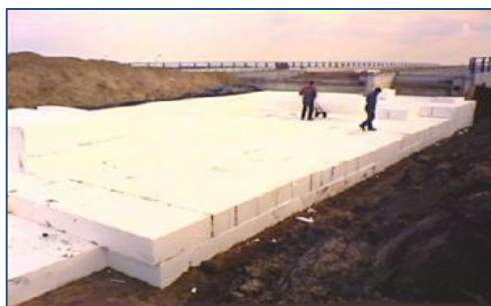
Figuur 26: Aanbrengen van EPS-blokken
