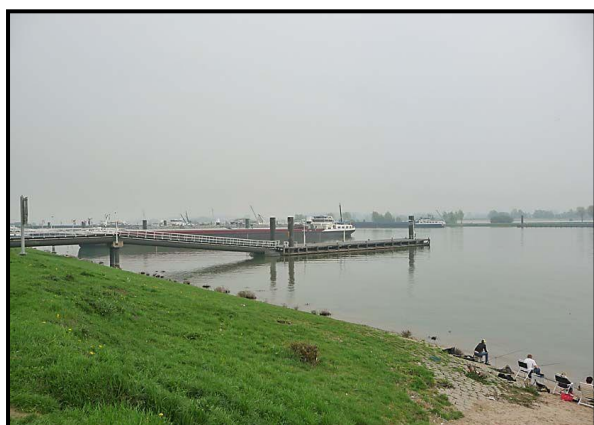
Figuur 9 Talud overnachtingshaven IJendoorn
