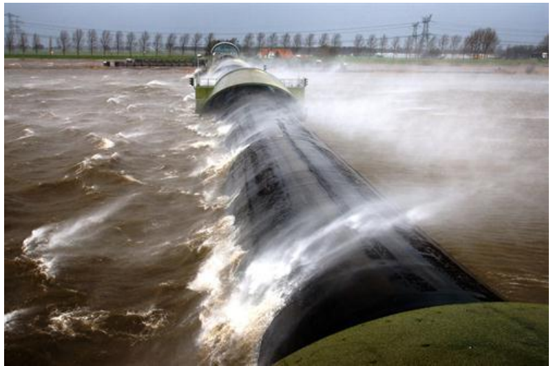
Figuur 5: Gesloten Ramspolkering bij storm op IJsselmeer (Waterschap Groot Salland, 2015)
