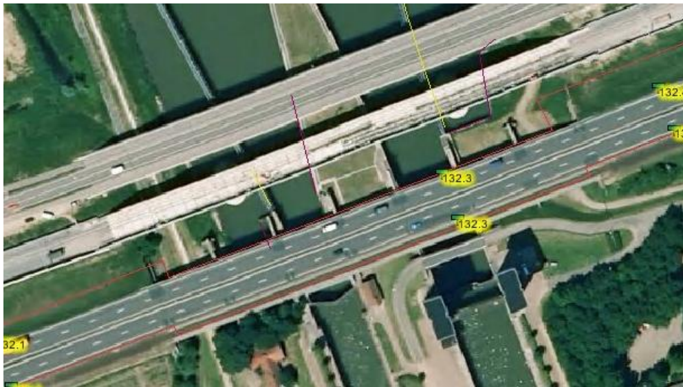
Figuur 11: Brug over het Amsterdam Rijnkanaal.
