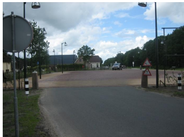
Figuur 7 - De entree van het plein in Siegerswoude. Paaltjes en lantaarnpalen zorgen ervoor dat de weg hier smaller lijkt.
