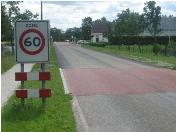
Figuur 8 - Voor het plein wordt aangegeven dat men snelheid moet minderen, door middel van een bord en een verandering van de kleur van het wegdek.
