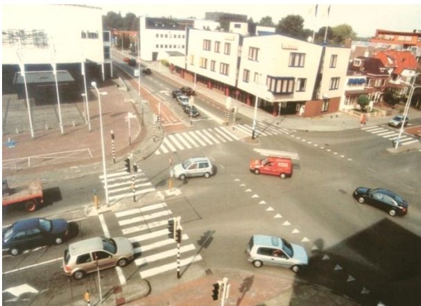
Figuur 29 - Voormalige situatie Laweiplein in Drachten (Shared Space Institute, 2009)
