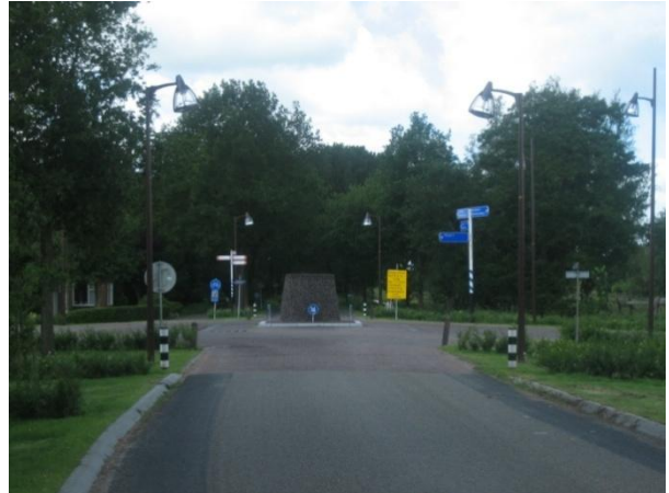
Figuur 10 - Vanwege de paaltjes en de lantaarnpalen lijkt de toegang naar het plein in Nij Beets smal. De opvallende stuke in het midden van het plein zorgt ervoor dat automobilisten op tijd zien dat er een kruising komt.
