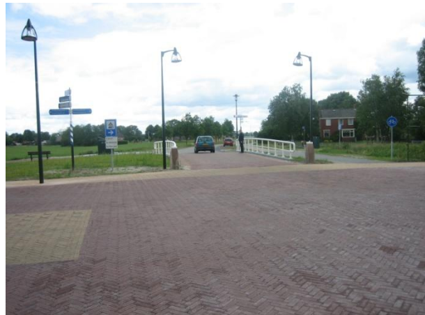
Figuur 9 - In Siegerswoude wordt door middel van een brug het verblijfsklimaat benadrukt.
