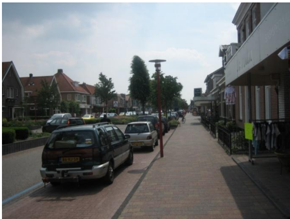
Figuur 43 - Het noordelijke gedeelte van de Julianastraat. Er is sprake van tweerichtingsverkeer.
