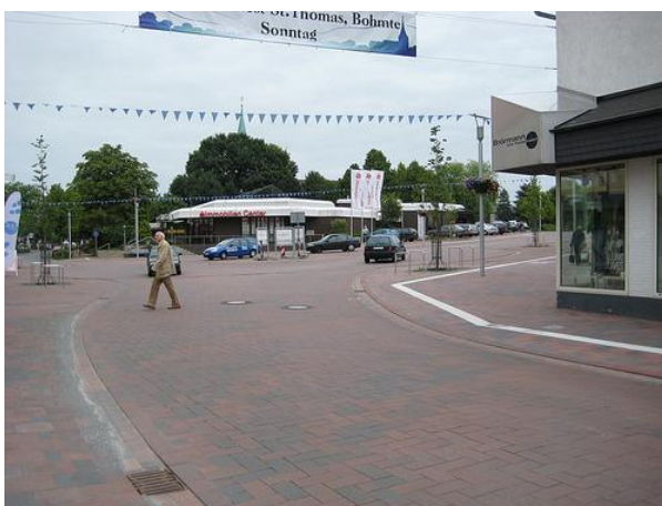
Figuur 57 - Het voetgangersgedeelte kan worden afgescheiden door middel van een afvoergoot, zoals is gedaan in Bohmte.
