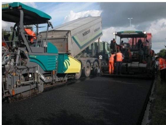
Figuur 6-7 Warm in warm draaien van asfalt
